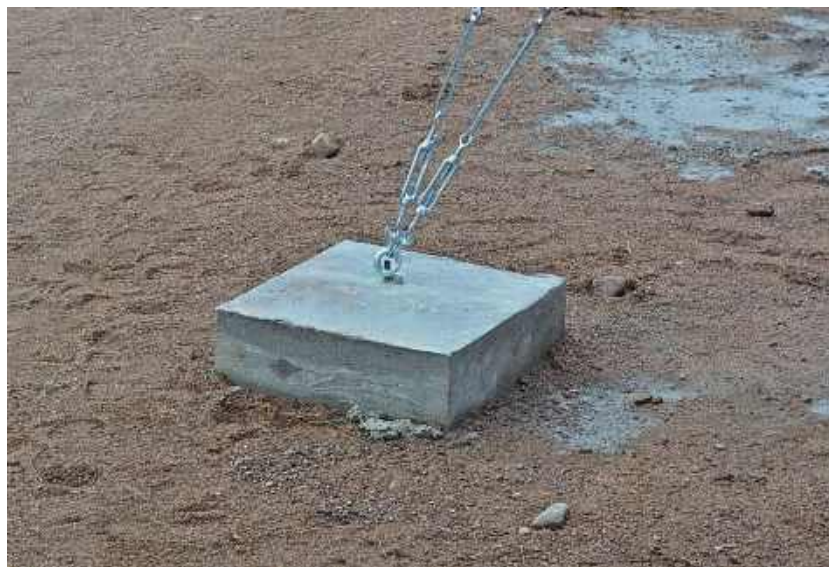
Рисунок 9 – Узлы крепления такелажа для растяжки мачты ВГ.
