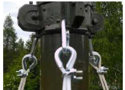
Способы крепления троса к на мачте.
