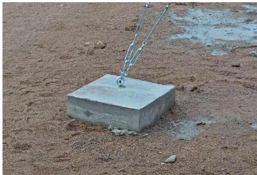
Рисунок 9 – Узлы крепления такелажа для растяжки мачты ВГ.
